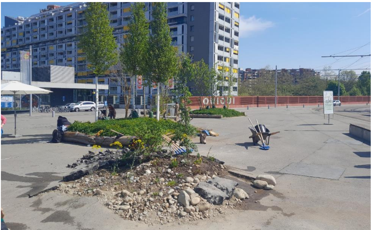
Entsiegelung und Begrünung als Massnahme zur Hitzereduktion auf dem Ansermetplatz in Bern. Bild: Moritz Gubler
